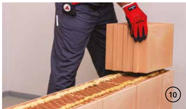
В рамките на максимум 2 минути от нанасянето на пяната се поставят керамичните блокове и се подравняват.
