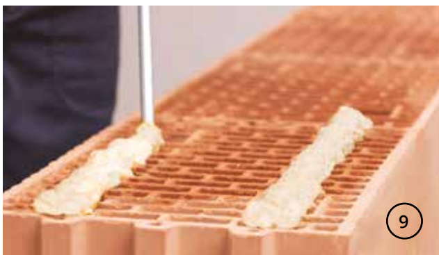
Нанесете две ивици от лепилото Porootherm Profi Dryfix Extra за Porootherm 25 Profi и за Porootherm 38 Izo Profi и една ивица за Porootherm 12 Profi на максимално разстояние от 5 cm от ръба на тухлата и с дебелина на ивицата около 3 cm.
