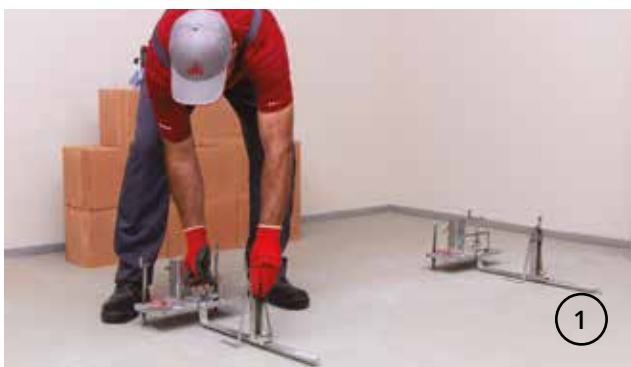
Очертайте контурите на стената и разположете нивелиращия инструмент за подравняване на първия ред.
