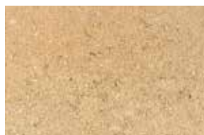
Видим бетон капучино
