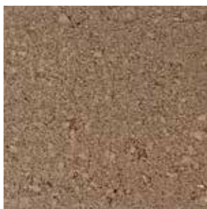
Видим бетон кафяв
